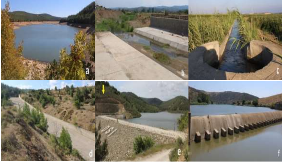
Fotoğraf 5: a) Salihler Göleti b) Akçin Çayı'nın Ezine il sınırında kanala alındığı yatağı c) Sulama Kanalı d) Gölet Kanalı e) Zeytinli Göleti ve yamaç tahribatları f) Truva Sulama Birliği Regülatörü (Pınarbaşı)
